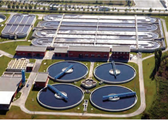
Şekil 7.6 Atıksu arıtma tesisi
